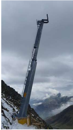
Lawinensprengmast, Lawinennetze und Lawinenverbauungen am Oberalppass (MGBahn)
