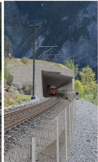
Murgang am Carrerabach / Steinschlaggalerie Aulta für Bahn und Wanderweg in der Ruinalta (RhB)
