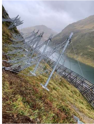
Lawinensprengmast, Lawinennetze und Lawinenverbauungen am Oberalppass (MGBahn)
