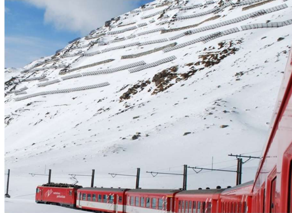
Lawinensprengmast, Lawinennetze und Lawinenverbauungen am Oberalppass (MGBahn)
